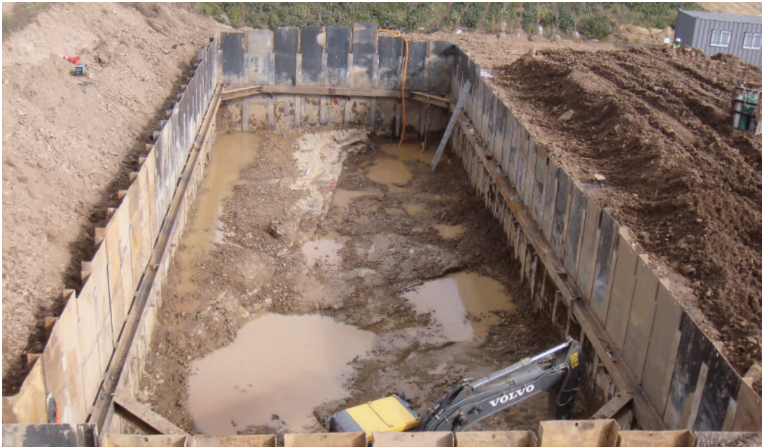
청주시 국도대체우회도로 (휴암~오동) 건설공사
