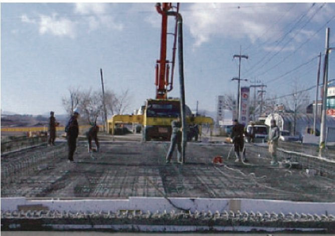
상부철근 배근 및 현장타설
