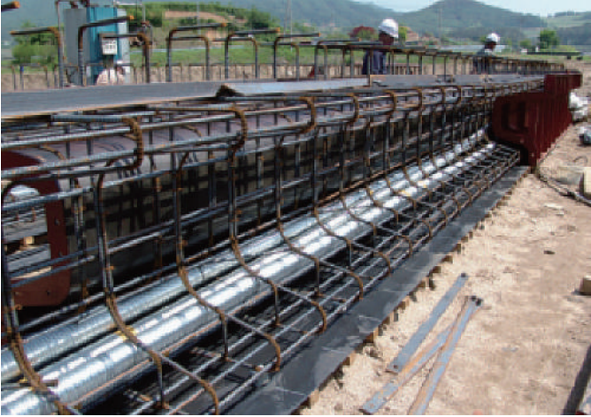
거더 철근 조립
