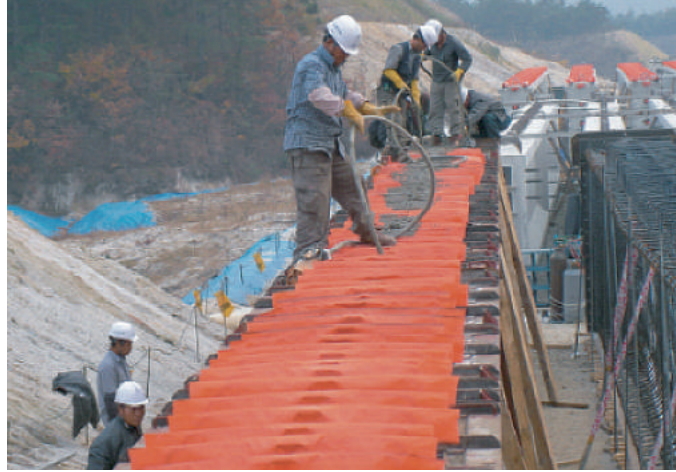
거더 콘크리트 타설
