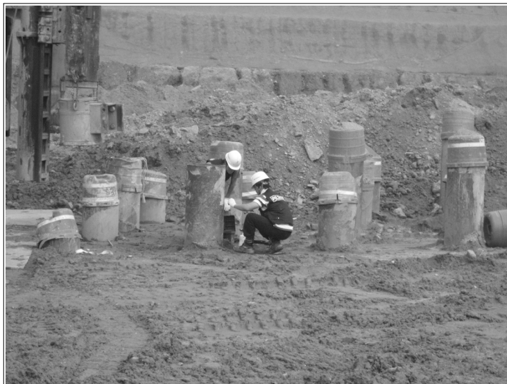
그림 13. 복합말뚝 시공 사례
