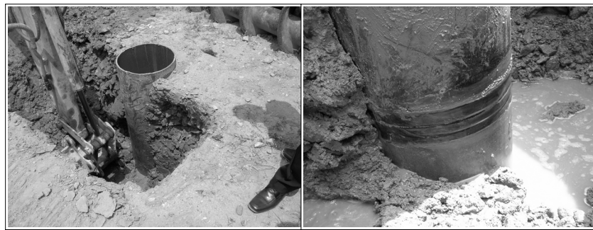
그림 5. HCP말뚝 항타 후 굴착 전경
